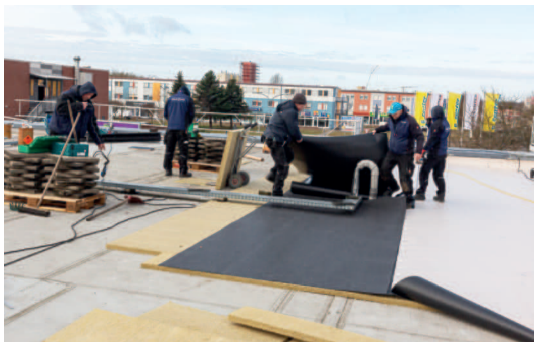
Die Arbeiten auf dem Dach des Oder-Center gehen zügig voran.
