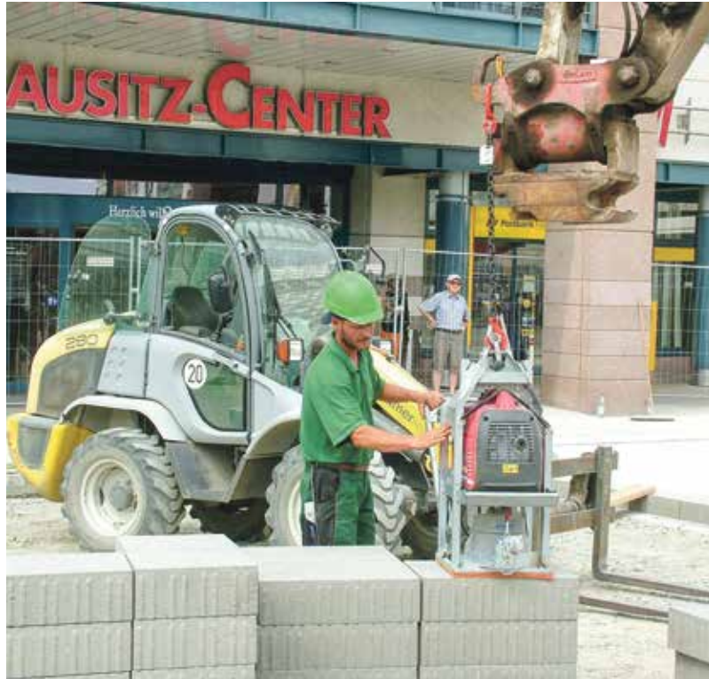
PRÄZISIONSARBEIT: – Falko Niemz dirigiert das Vakuumsauggerät an eine Platte. Gut erkennbar: die besondere Stabilität schaffenden „Verzahnungen“.
